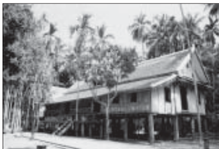
Villa Ban Xiengmouane rénovée
