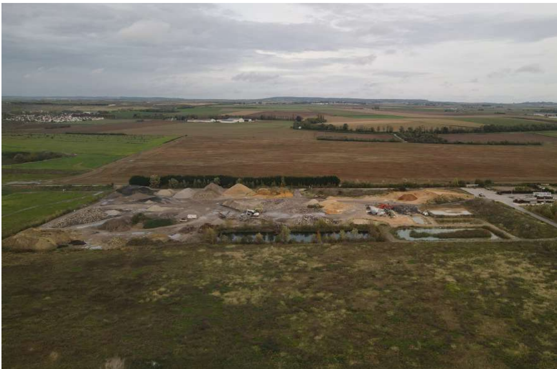
Photo aérienne haut : Sablières de Meaux Photo aérienne bas : Plateforme de valorisation Valomat
