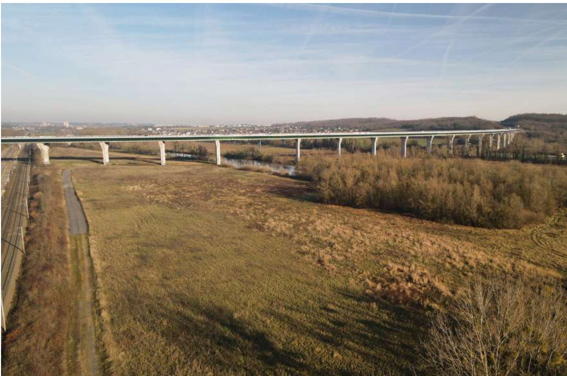
Photo aérienne haut : LGV Est européenne Photo aérienne bas : Viaduc de Meaux A140
