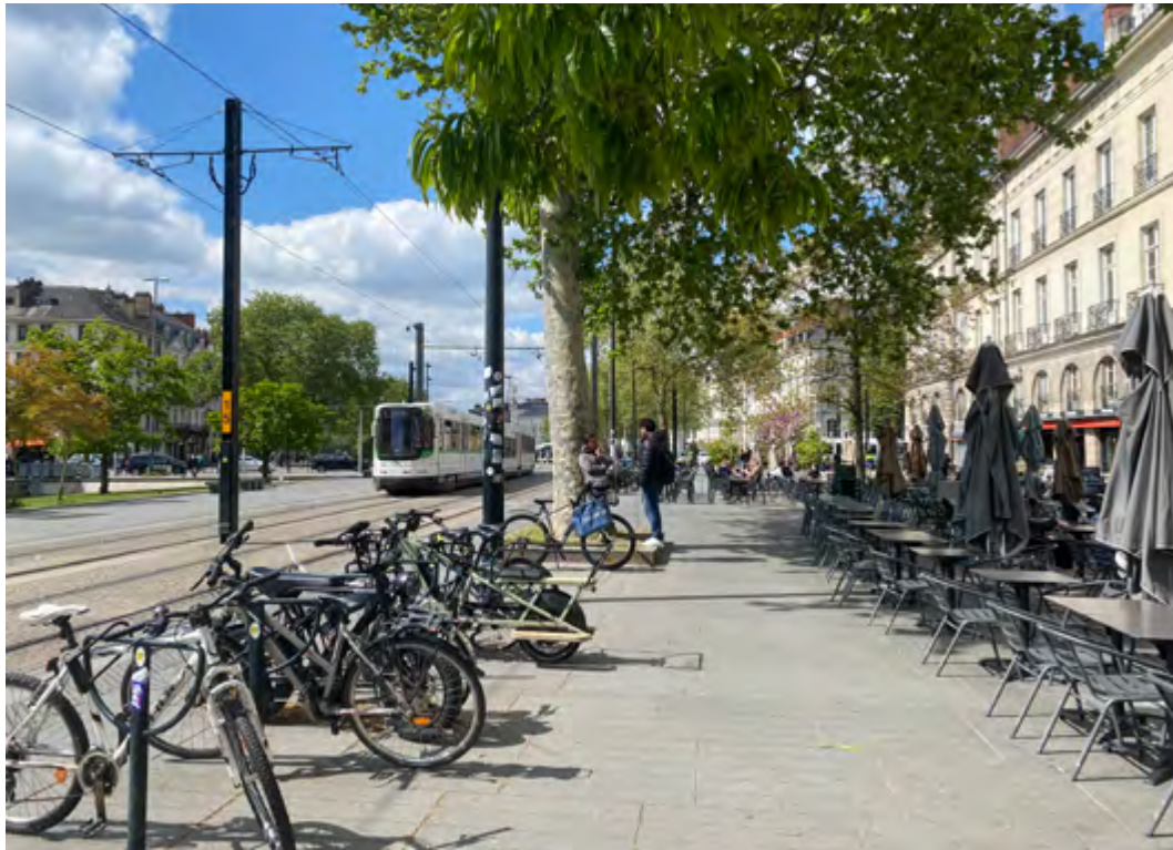
Les abords de la ligne de tramway © Inès Bizid
