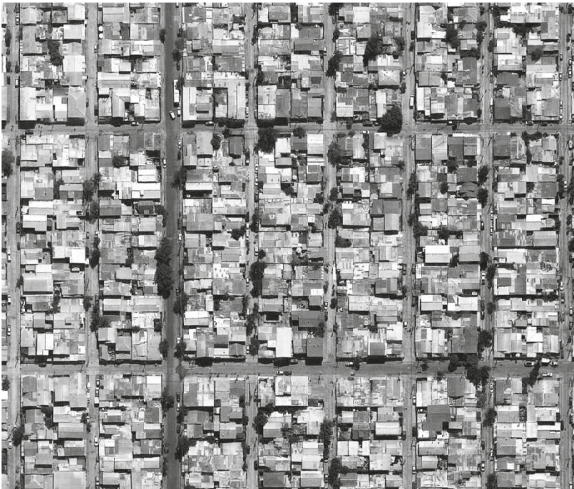
Carte : Croissance de Santiago Vue aérienne : La Pintana, la forme urbaine de la périphérie
