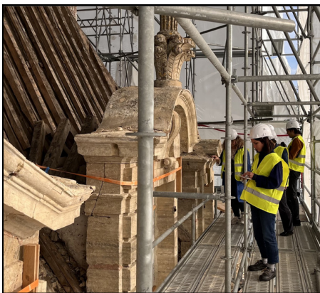
étudiants du DSA patrimoine sur un chantier
