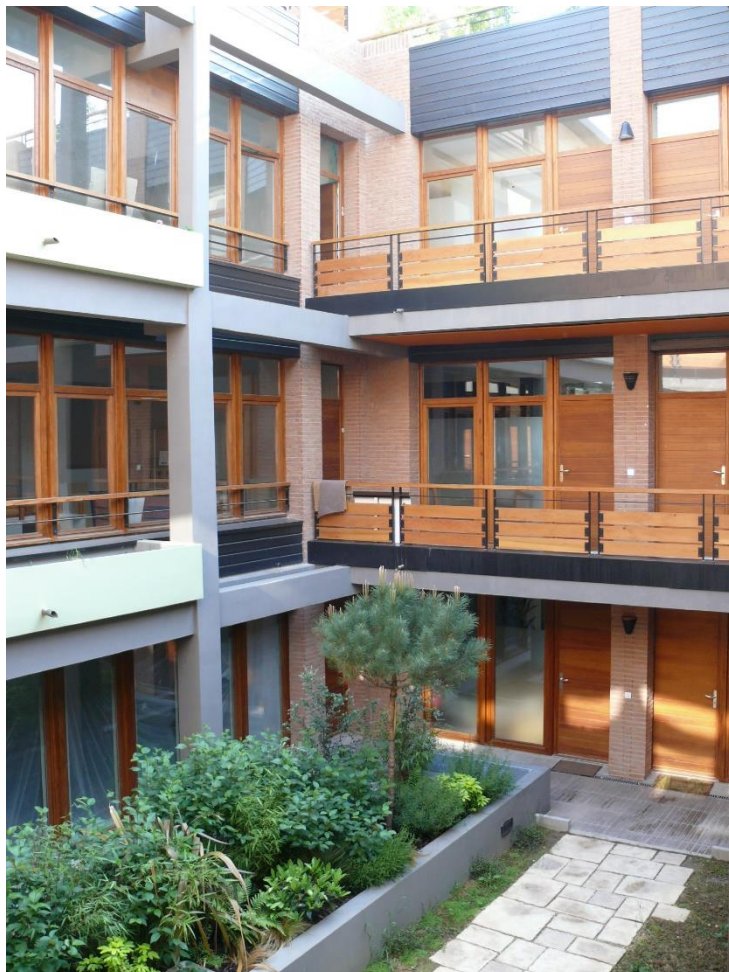
Ancien bâtiment d'activité, avenue du Président Wilson (RN1) à Saint-Denis (Seine-Saint-Denis - Île-de-France - France) en fond de parcelle aveugle, transformé en logements en accession à la propriété, éclairé par un large puits de lumière. Photographie : Claude Villeteuse, 25/05/2008 (CC BY-SA 3.0, Wikimedia Commons)
