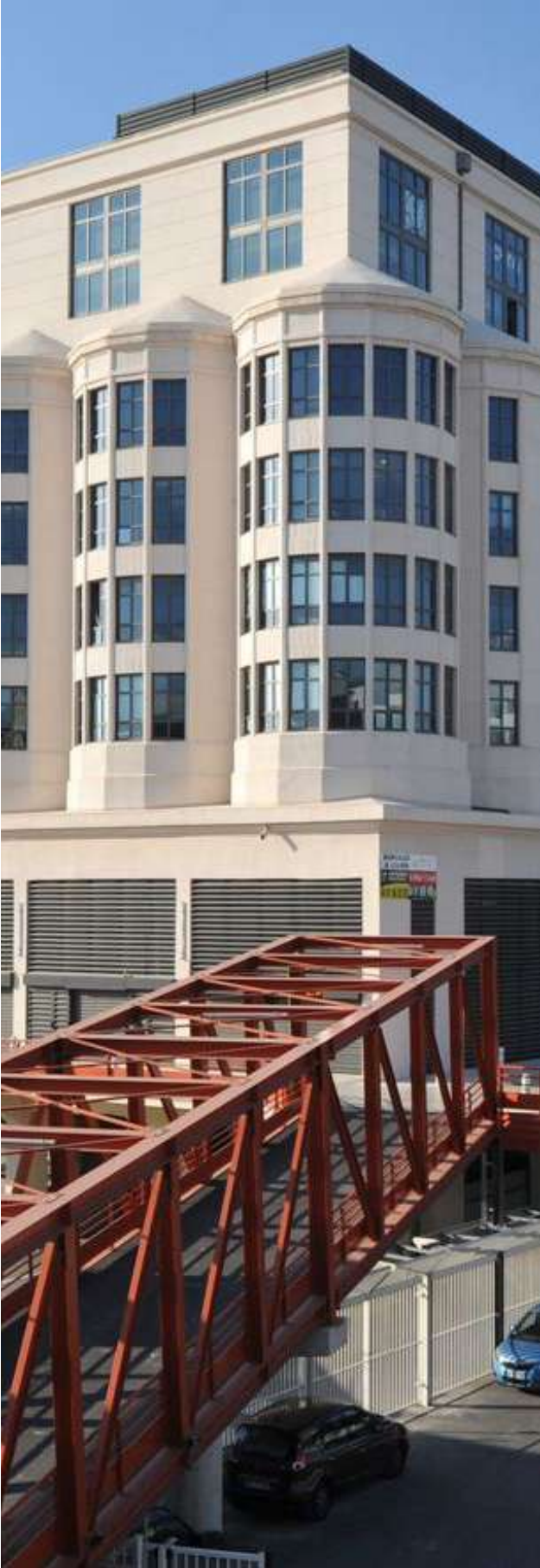
Fig. 2. Le silo d'Arenc à Marseille Source: Le Moniteur
