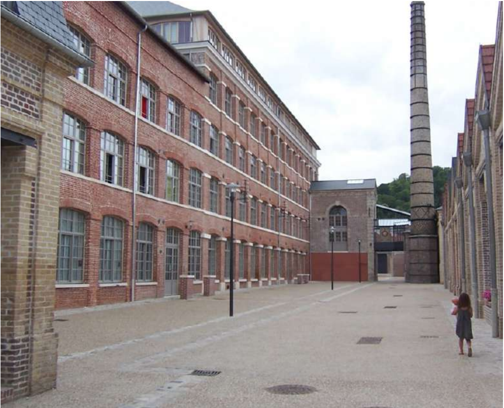
Fig. 1. L'usine Gasse et Canthelou à Elbeuf Source: L'observatoire CAUE
