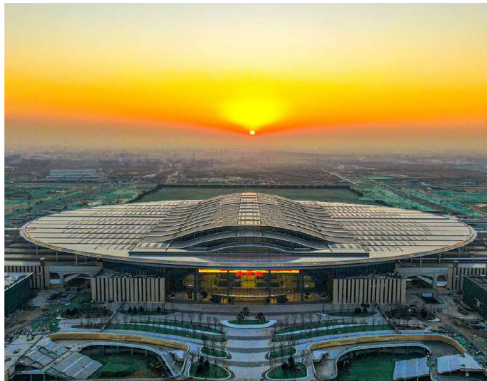
Fig. 4. Une vue plongeante sur le toit de la gare de Xiong'an Source: french.china.org.cn
