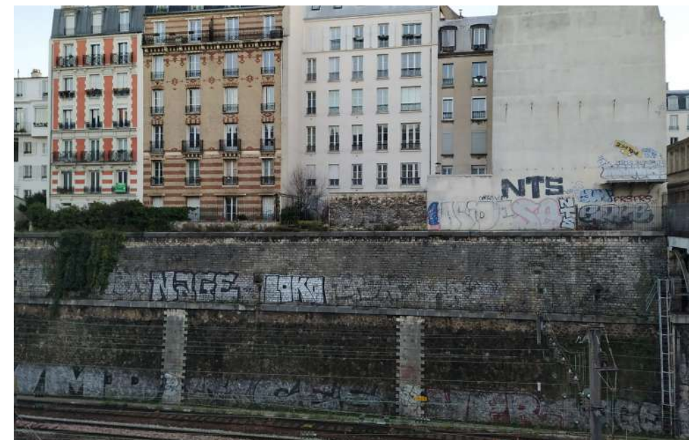
Photo 3 - La barrière entre la ligne ferroviaire et la Rue de Rome.
