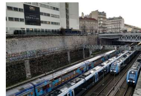
Photo 2 - Les façades en face de la ligne ferroviaire.
