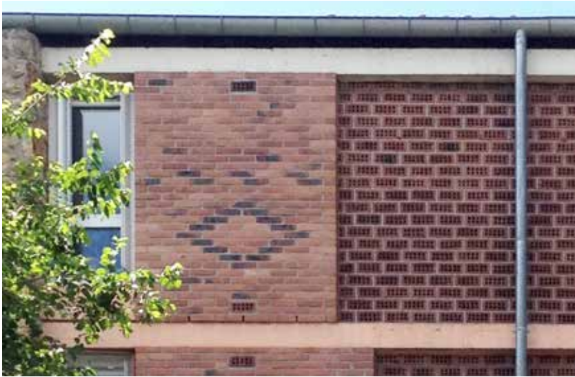
Figure 21 : Détail de façade des Briques Rouges.
