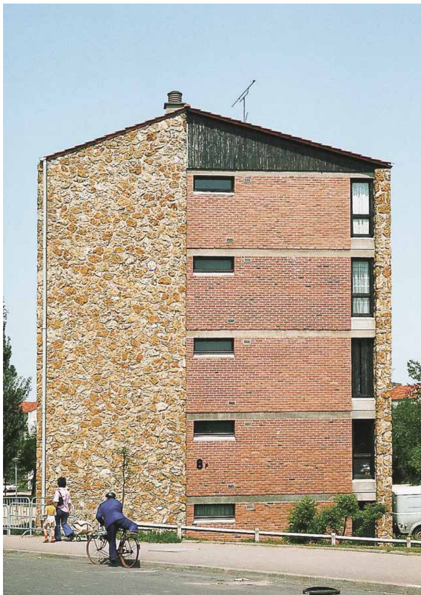
Figure 19 : Vue d'un bâtiment des Briques Rouges.
