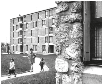
p. 84 : Les Briques Rouges , 1960-65.
