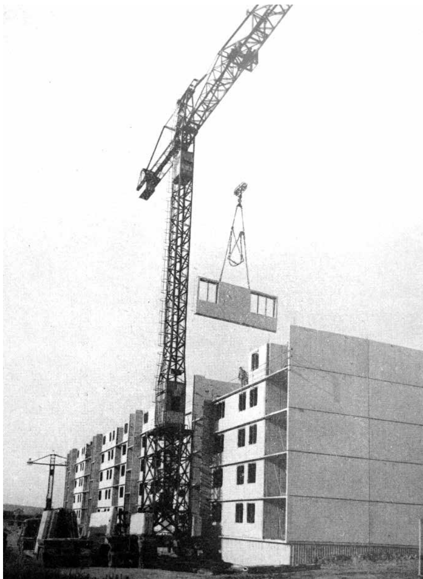
Figure 2 : Montage d'un panneau par le procédé Camus. Tiré de Techniques et Architecture, 17ème série, n°5, novembre 1957.
