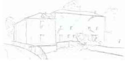
Premier moulin non réhabilité : le moulin du Pré
