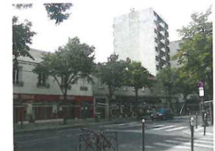
PD 3 - PHOTOS des bâtiments à démolir
