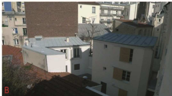
B VERS LE 17 RUE MADEMOISELLE VUE DEPUIS LE 3EME ETAGE
