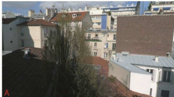
A VERS LE FOND DE PARCELLE / BATIMENTS DE LA RUE LAKANAL VUE DEPUIS LE 3EME ETAGE
