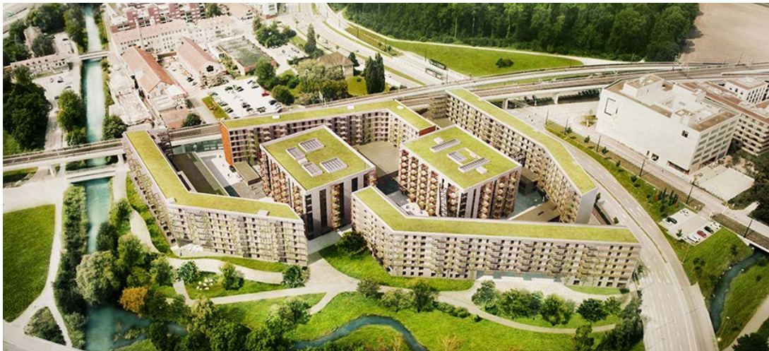
Ci-dessus : L'ensemble de l'opération de Zwicky Süd
