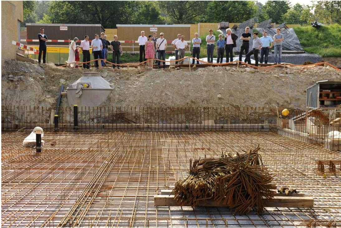
Ci-dessus : Visite de chantier pour les membres de la coopérative
