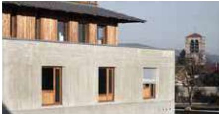
Mur en béton banché. Maison de retraite, Arlanc (63)
