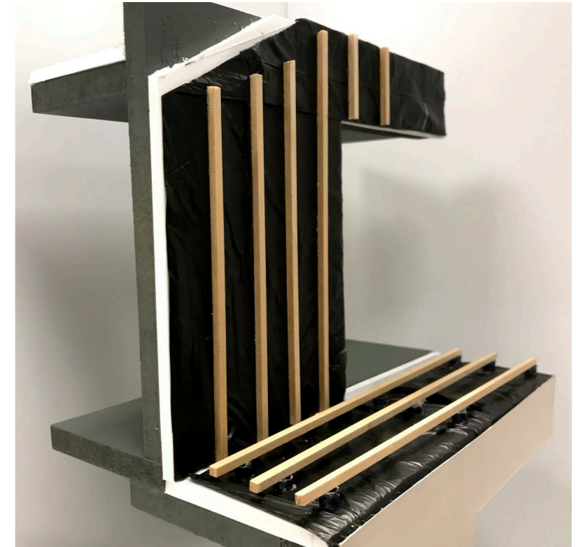
3-Pose des tasseaux et plots, puis de l'enduit minéral
