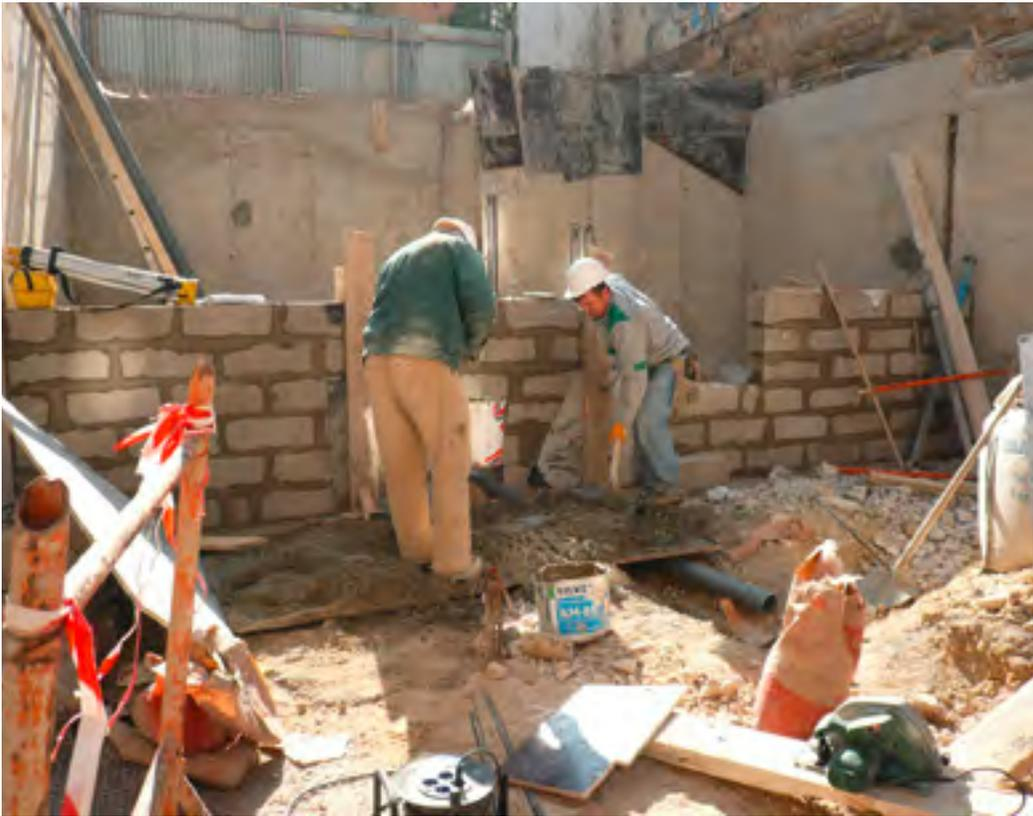
La structure se constitue entre béton coulé, banches et parpaings
